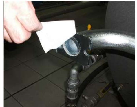
6) Снять заглушку из Труба ГАЗОВОЙ рампы;
