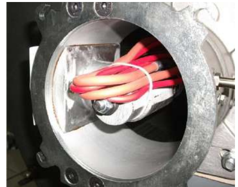
9) Отсоединить кабель электрода поджига и кабель электрода ионизации из СМЕСИТЕЛЬНАЯ ГРУППА;
