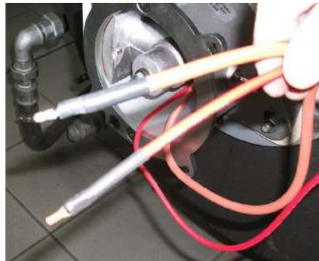
5) извлечь через отверстие для прохода кабелей кабель электрода поджига и кабель электрода ионизации, которые в свою очередь должны остаться жестко прикрепленными к смесительному узлу;
