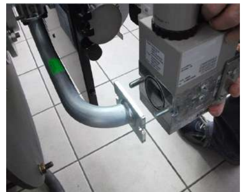
9) установить электроклапан на Труба ГАЗОВОЙ рампы;
