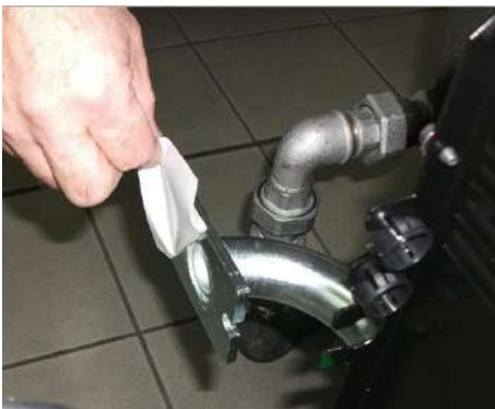
7) Снять заглушку из Труба ГАЗОВОЙ рампы;
