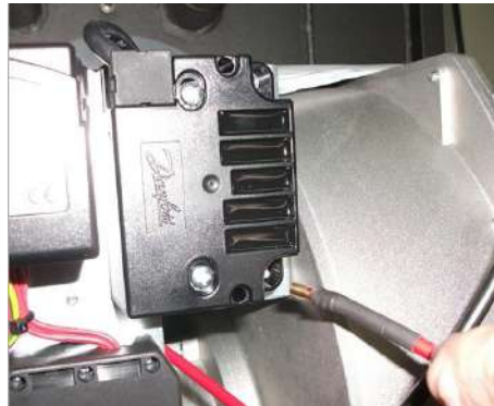
14) Подсоединить кабель поджига к трансформатору;
