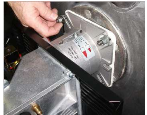
6) Зафиксировать горелки на котел;
