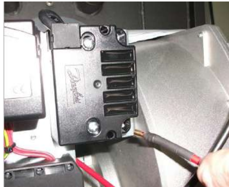
2) Отсоединить кабель электрода поджига от трансформатора;
