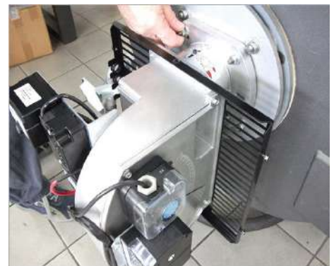
6) Зафиксировать горелки на котел;
